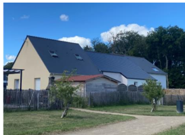
Maison individuelle groupée à Saint-Augustin-des-Bois
