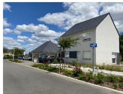
Construction au Lion d'Angers sur le lotissement DURVAL 5 où 49 lots de 371 à 785 m 2 ont été commercialisés en 2021. Crédit photographique : MERC/AT.
